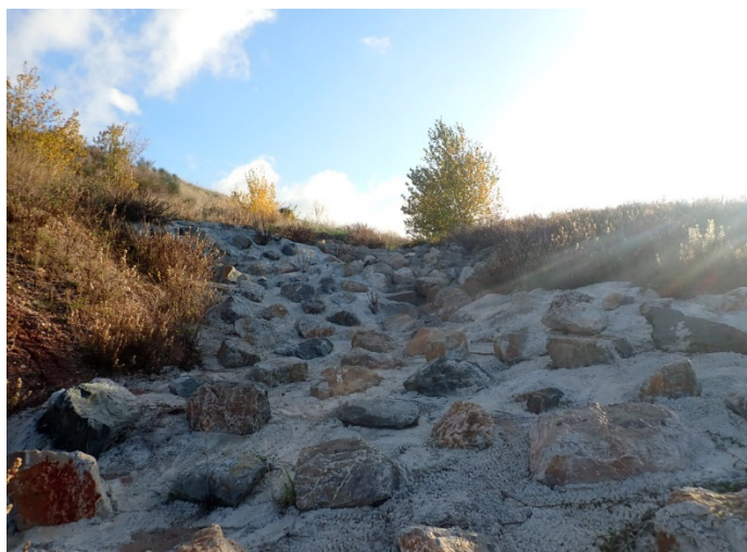
Illustration 30 : Enrochements bétonnés en amont du bassin d'orage, en bon état
