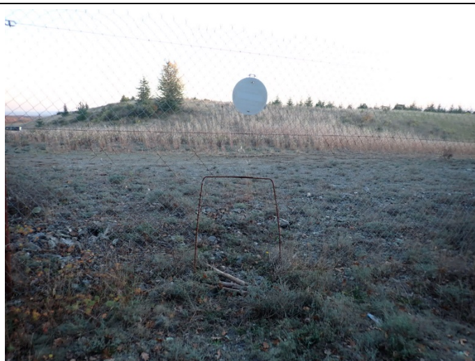
Illustration 37 : Panneau de restriction d'accès à remplacer le long de la clôture au niveau d'un passage faune
