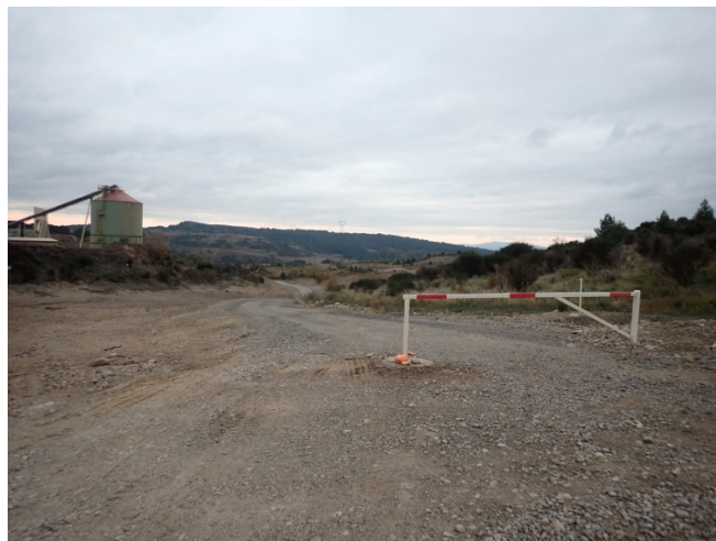
Illustration 2 : Piste de circulation principale depuis l'accès Nord en bon état
