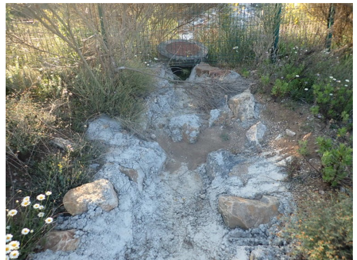
Illustration 8 : Accumulation de sédiments dans l'entonnement en amont de la station de traitement
