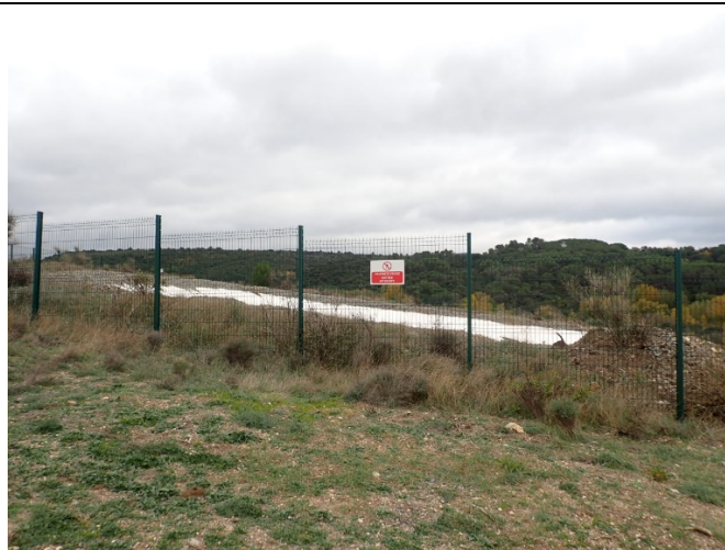
Illustration 3 : Panneau de restriction d'accès en bon état le long de l'alvéole big-bag
