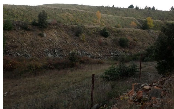
Illustration 45 : Eboulis localisés sur une banquette de la bordure Ouest de la MCO
