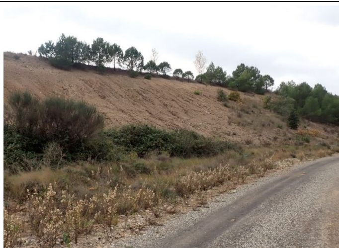
Illustration 5 : Portion du versant séparant les plateformes Nord et Sud, raviné
