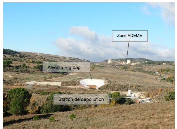
Illustration 12 : Vue générale des zones ADEME et du Monitoring, station de traitement au premier plan
