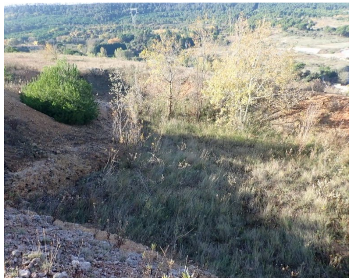
Illustration 34 : Bassin d'orage partiellement végétalisé à l'Ouest du site
