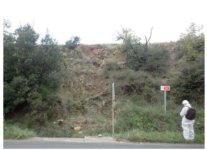
Illustration 22 : Zone de ruissellement le long de la RD101 et panneau de restriction d'accès en bon état
