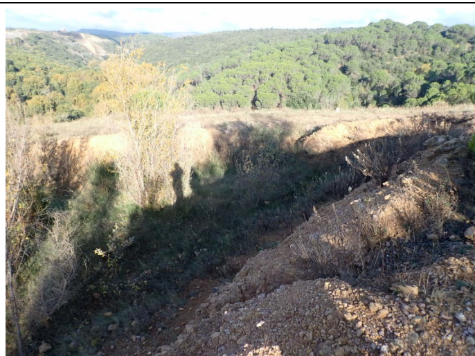
Illustration 36 : Fossé drainant Nord-Ouest
