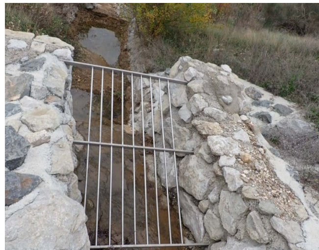
Illustration 18 : Dépôt de sédiments dans le bassin aval du dégrilleur
