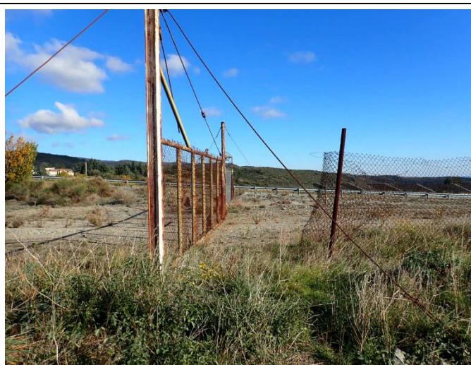
Illustration 38 : Grillage vandalisé au droit de l'ancien portail d'accès
