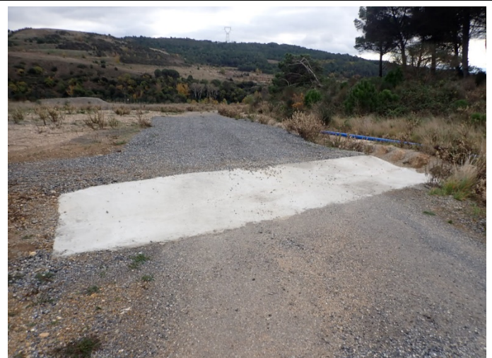
Illustration 10 : Reprise de caniveaux sur la piste ADEME
